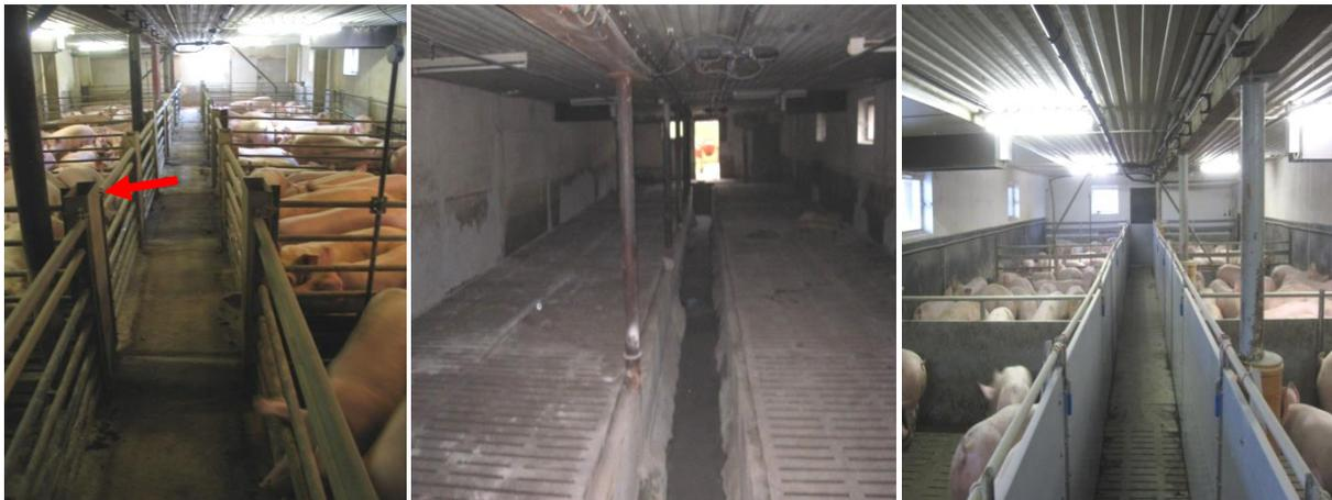
Abb. 21: (links) Abteil mit Unterflurzuluft über Röhren ins Abteil (roter Pfeil)
