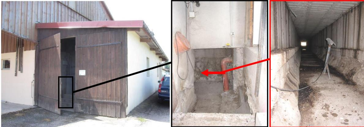
Abb. 22: (rechts) Ansaugen der Frischluft durch das Tor
