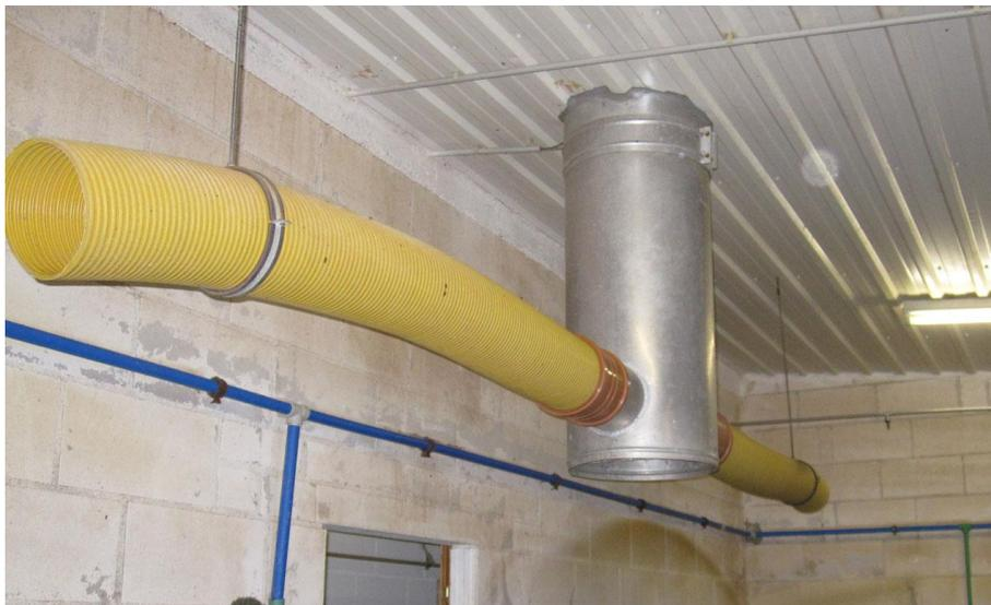
Abb. 20: Dezentraler Abluftschacht mit an der Unterseite befindlicher Schwerkraftklappe am Betrieb A (Erdwärmetauscher).
