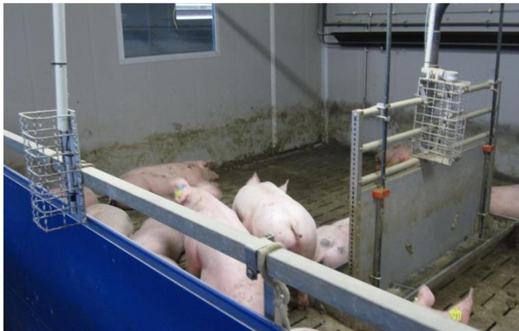
Abb. 56: Beide Temperaturfühler im Abteil der Unterflurlüftung. Der Fühler links im Bild (Punkt (4)) zeichnet die Temperatur der Frischluft auf, wenn sie über die Buchtentrennwand zu den Tieren steigt. Der Fühler am Trog (Punkt (5)) zeichnet die Abteiltemperatur auf.
