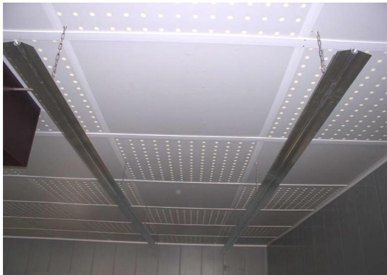
Abb. 16: Porendecke im Schachbrettmuster und Heizungsrohre (Deltarohre) zur Erwärmung der einströmenden Luft. (GEIßLER, 2010)
