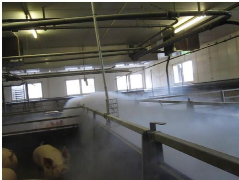
Abb. 18: Luftpfeile im Winter in Abteil C3 (Unterflurzuluft)
