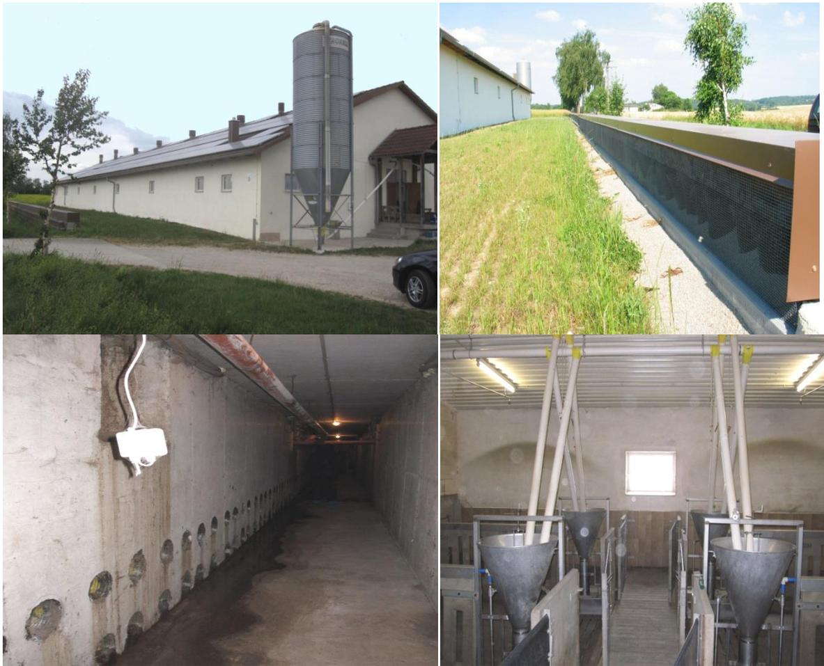
Abb. 19: (oben links) Erdwärmetauscher-Betrieb ( oben rechts) Ansaugseite Rippenrohre
