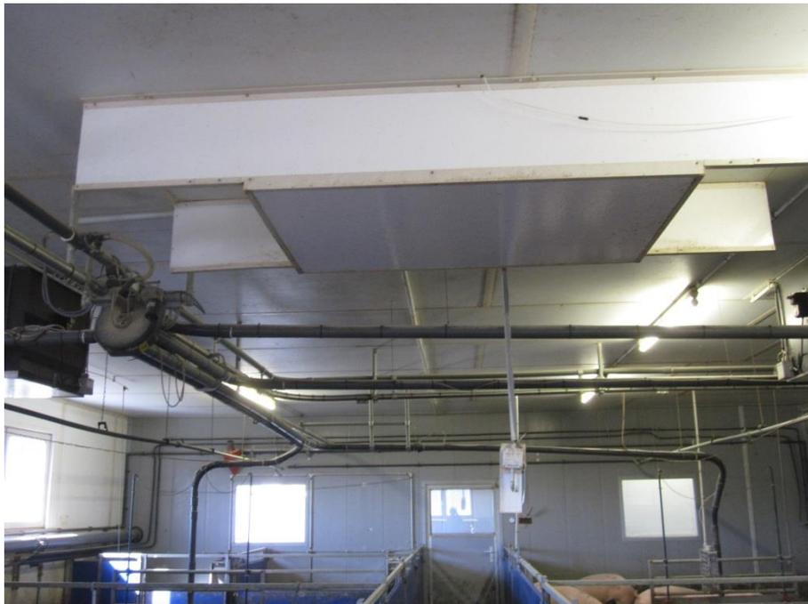
Abb. 15: Abluftkasten zur Verhinderung eines Lüftungskurzschlusses bei der Unterflurluft
