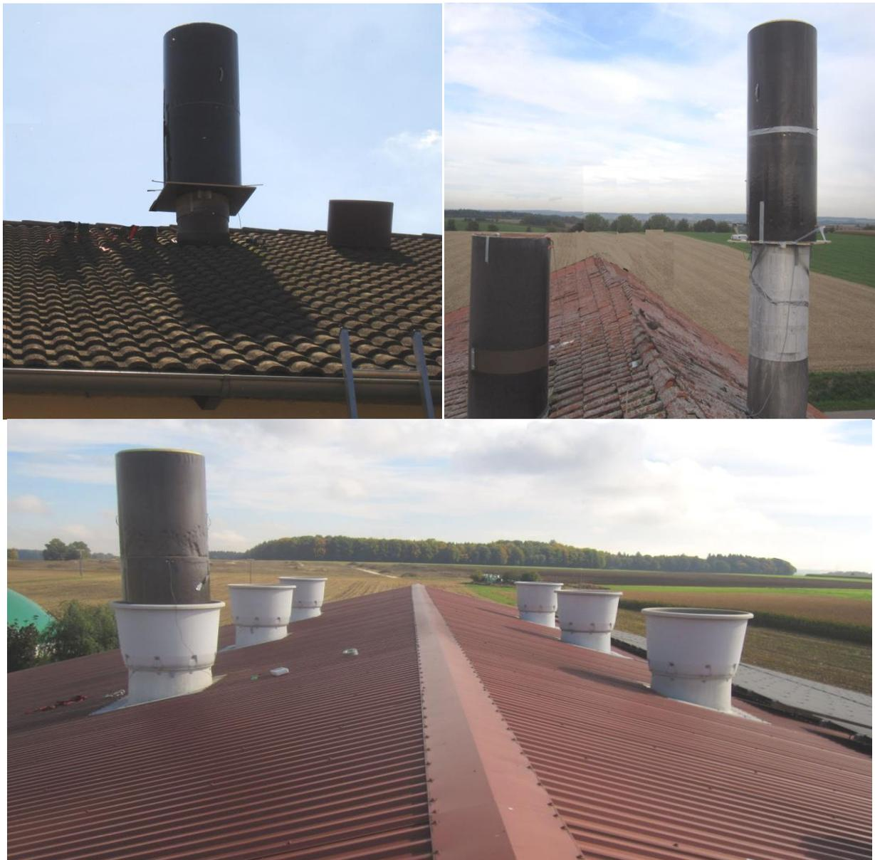
Abb. 32: Kalibration der Messventilatoren auf den Praxisbetrieben. (oben links) Betrieb A Erdwärmetauscher; (oben rechts) Betrieb B Unterflurzuluft; (unten) Betrieb C Hochdruckbefeuchtung
