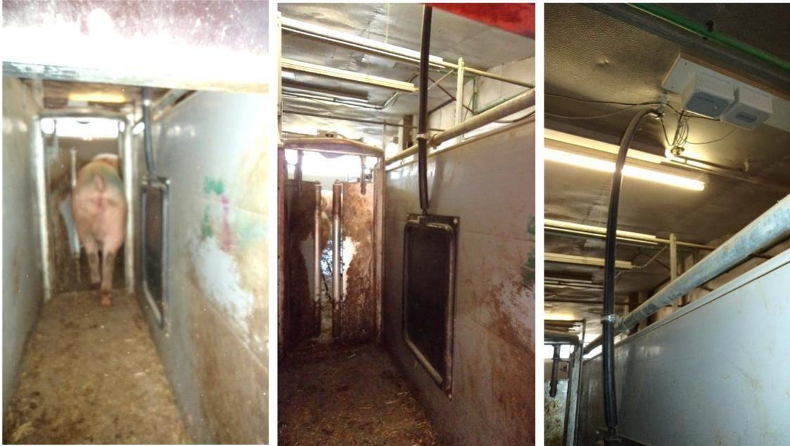
Abb. 26: Konstruierter Gang mit Schleusentür (links) und RFID-Antenne zur Registrierung (mittig) mit dazugehörigem RFID-Lesegerät und Stromversorgung (rechts)
