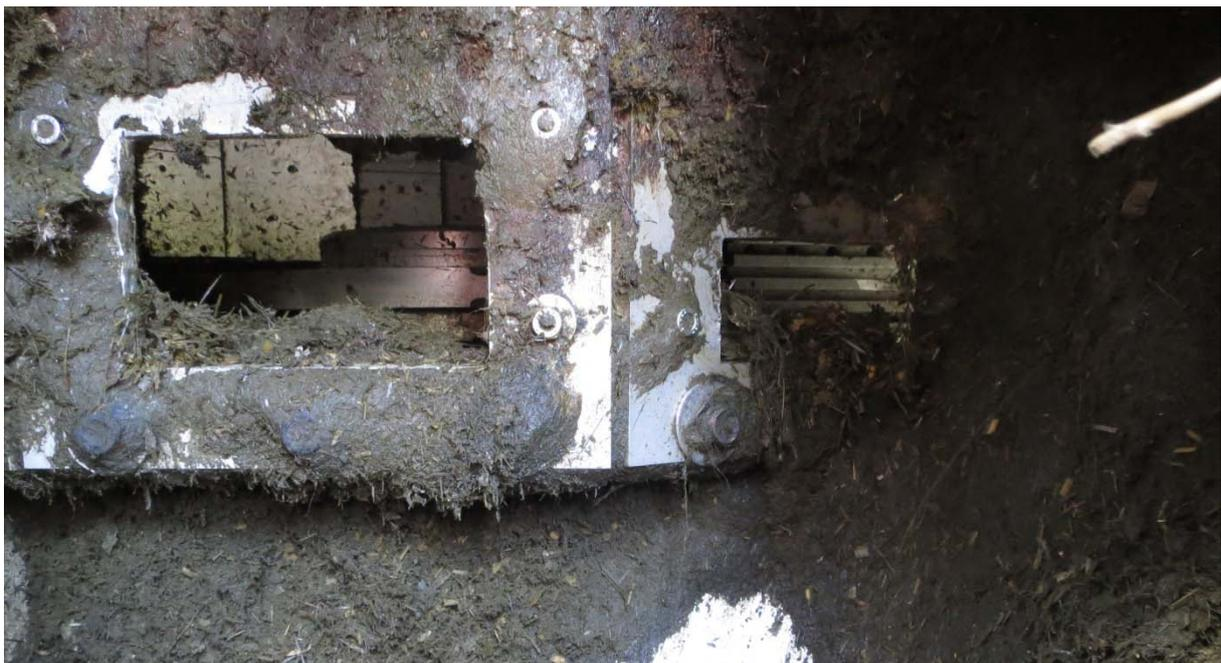
Abbildung 5-49: Siebplatten des Prallreaktors der Biogasanlage Sehanu
