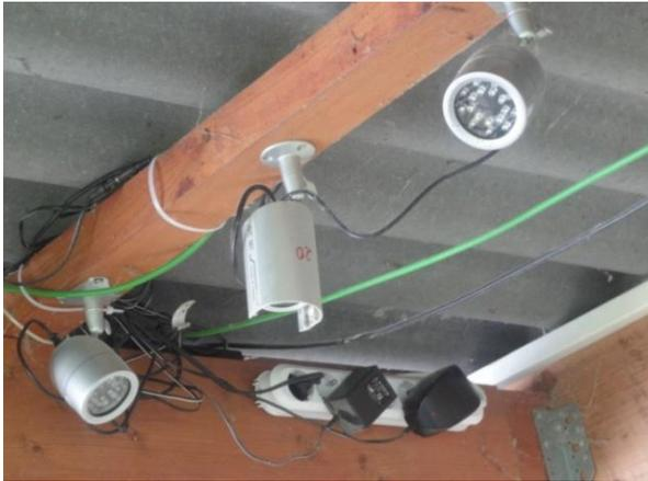
Abb. 16: Digitale Videotechnik mit Analogkameras
