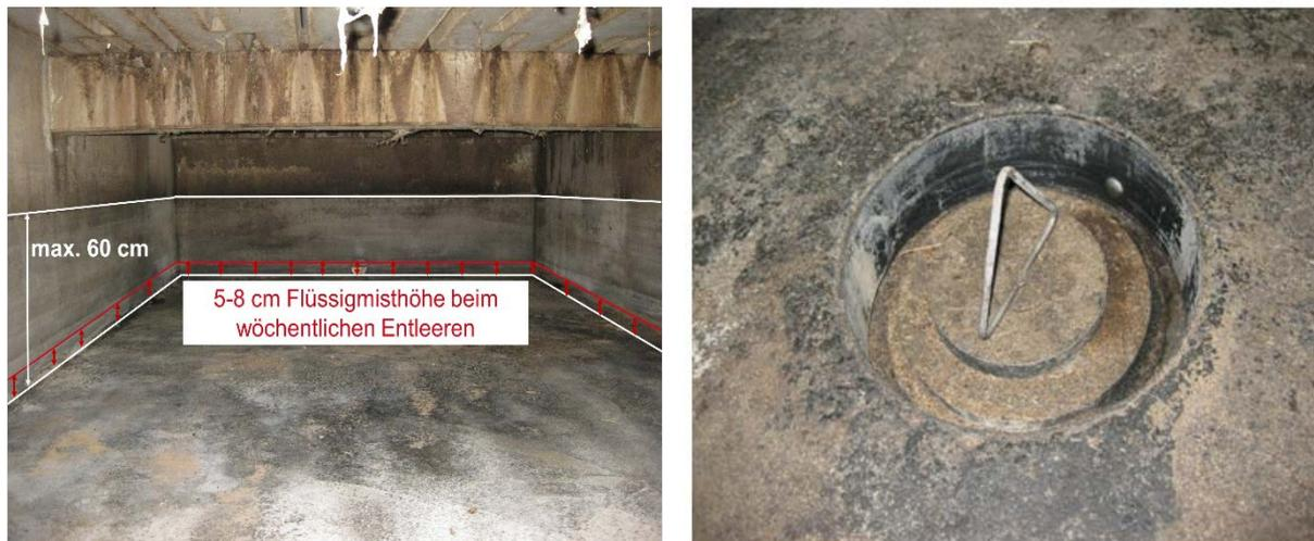
**Abbildung 3:** Abbildung eines leeren Flüssigmistkanals im Versuchsabteil (links) mit der Kennzeichnung der Höhe des Flüssigmistpegels beim üblichen Staumistverfahrens (weiße Linie) und der Höhe des Flüssigmistpegels im Versuch (rote Linie) sowie das Bild eines Ablassstopfens (rechts) im Boden des Flüssigmistkanals
